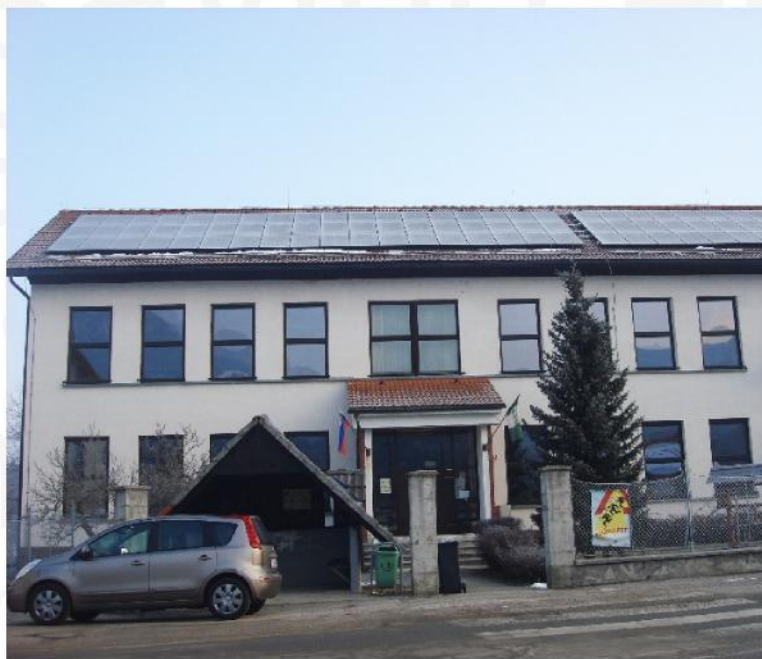
Solarni sustav na školskoj zgradi
